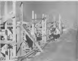
E EDIFICIO di e stacion, cu ta worde construi pa Bohama, ta tumando forma y dak ta cerca di hanta. Trahadornan di Bohama, banda drechi, ta traha e muraya rond di e stacion. Aki nan ta prepara e fundeshi di concreto.
